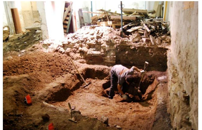
FOTO 14. Excavació manual de la cala
