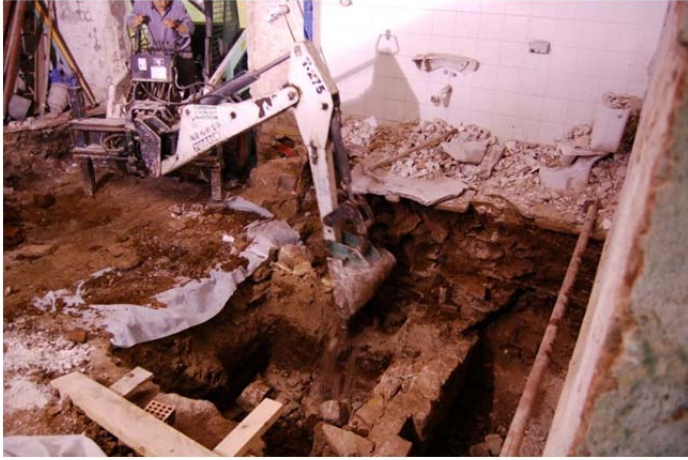
FOTO 41. Eliminació mecànica (zona 3)
