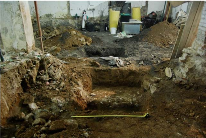
FOTO 25. Riosta actual a la zona 1
