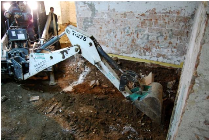
FOTO 19. Obertura mecànica de la cala a la zona 3
