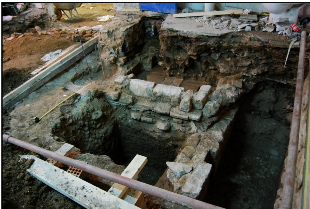
Vista general del sondeig per a la instal·lació de l'ascensor.
