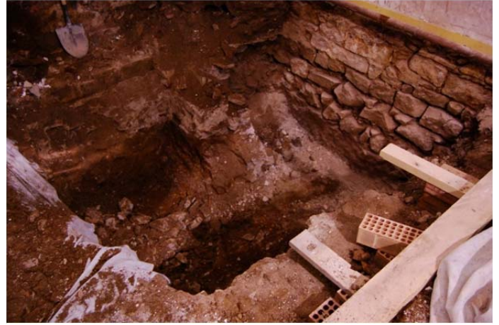
FOTO 42. Vista final de la cala a la zona 3
